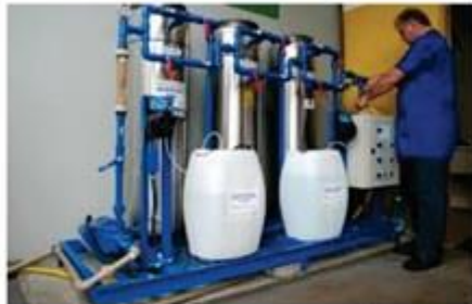
Unid.Compacta de Reuso de Água
